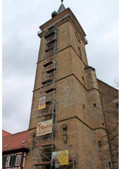
Gut 30 Meter hoch ist das Gerüst an der Westfassade der Stiftskirche. Fotos: Hohl
