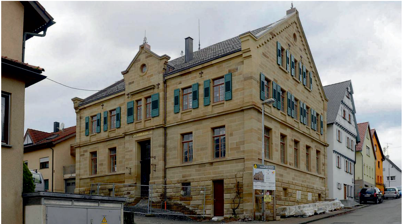
Bis 1970 erfüllte die Alte Schule in Eberstadt ihre Funktion, dann drohte das imposante Gebäude zu verfallen – zum Glück kam es anders. Foto: Mario Berger
