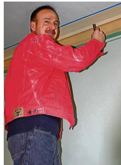
Restaurator Klaus Hub ist im alten Schulhaus zugange.
