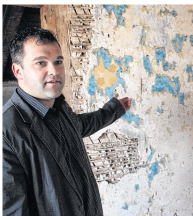
Zig Schichten tragen die Wände: von Strohmatten und Putz bis zu Tapeten.
