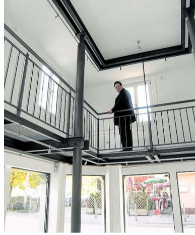
Im Inneren entstand eine Galerie, für die eine Zwischendecke entfernt wurde.
