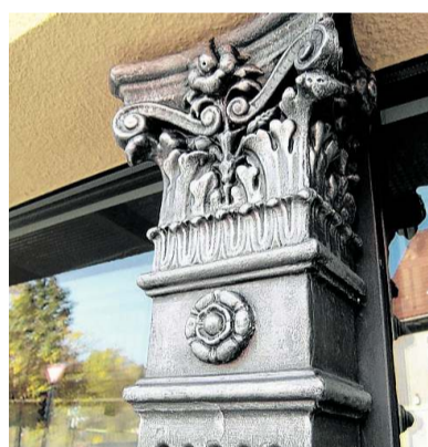
Im Detail liegt der Reiz, etwa in den gusseisernen Säulen. Fotos: Henry Doll
