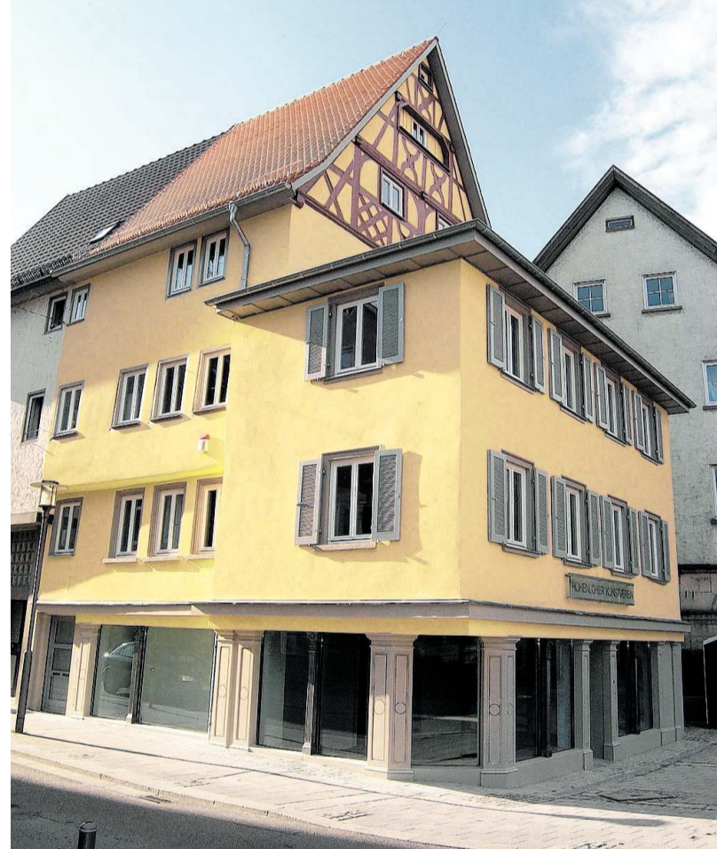
Eine Besonderheit des Hauses sind die gusseisernen Stützen und die Sandsteinsäulen im Erdgeschoss. Bewusst wurden daher rahmenlose Fenster eingebaut.
