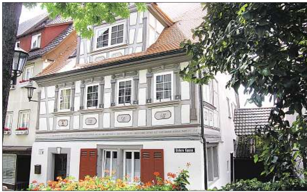
Das Fachwerkhaus in der Unteren Gasse 1 zählt zu den schönsten Häusern Forchtenbergs. Der Besitzer hat das 250 Jahre alte Gebäude in Zusammenarbeit mit dem Denkmalamt innen und außen saniert. (Fotos: Hagen Stegmüller)
