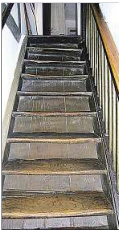
Noch im Original-Zustand befindet sich die Treppe hoch zum Speicher.
