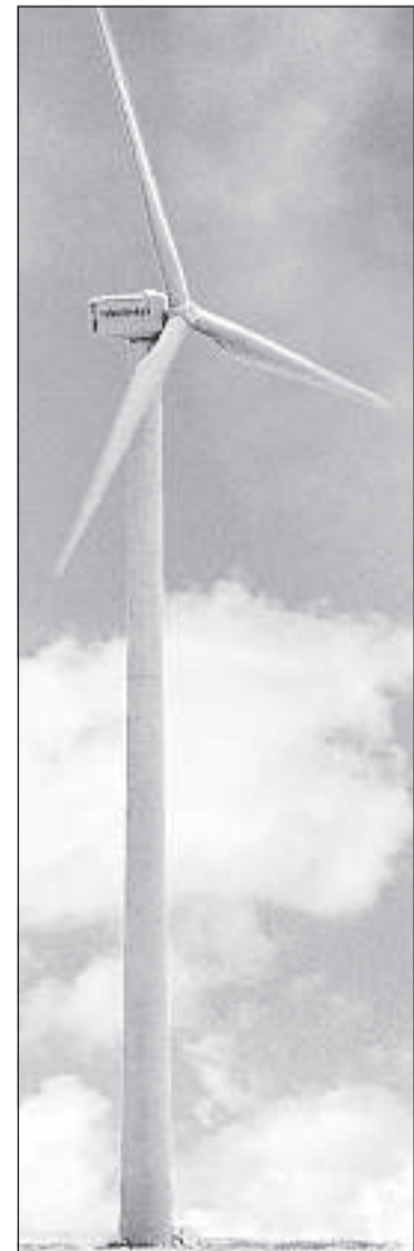
In der Nähe von Schrozberg installiert der Bürgerwindpark Hohenlohe eine Windkraftanlage.
